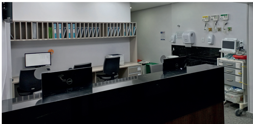
Posto de Enfermagem leitos
